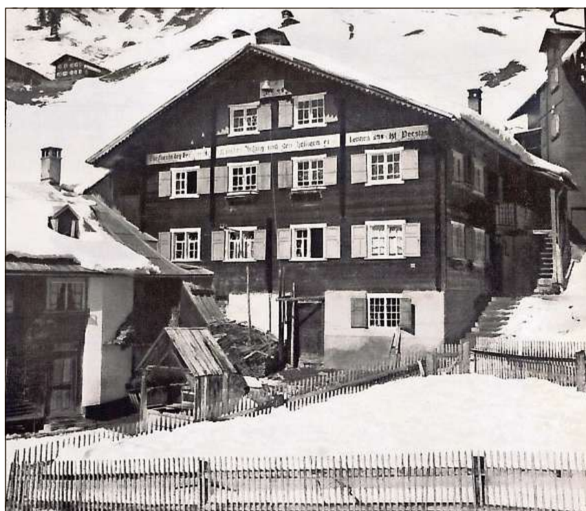
S. Antònia – ina da las numerusas chasas da scola che derivan dal temp da l'obligatori da scola dals onns 1840.
